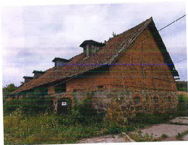
Zdjęcie 13. Budynek jałownika w dawnym zespole dworsko-folwarcznym z miejscowości Chojniak, pocz. XX w. Fot. własna, 2024
