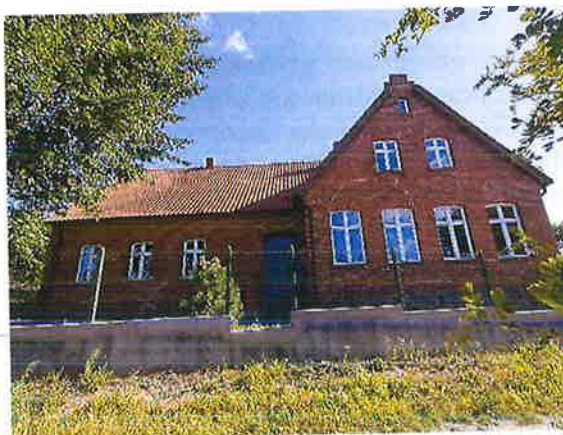
Zdjęcie 24. Budynek szkolny w Szeligach, obecnie świetlica. Fot. własna, 2024
