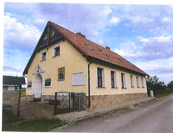
Zdjęcie 20. Budynek szkolny, ob. cerkiew grekokatolicka w Chrzanowie. Fot. własna, 2024
