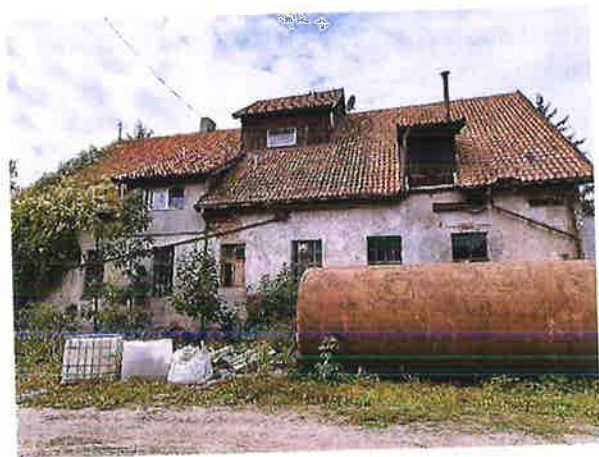
Zdjęcie 30. Gorzelnia w Stradunach, ob. opuszczona. Fot. własna, 2024
