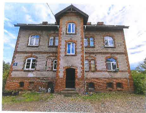
Zdjęcie 26. Dom pracowników kolejowych w Chrzanowie. Fot. własna, 2024
