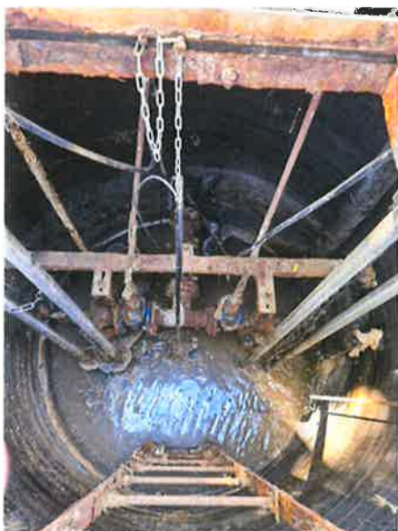
Rys. nr 3 Przepompownia Oracze przed modernizacją. (źródło własne)
